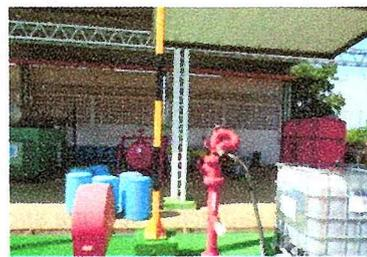
**Hidrante con tanque de espuma.**
